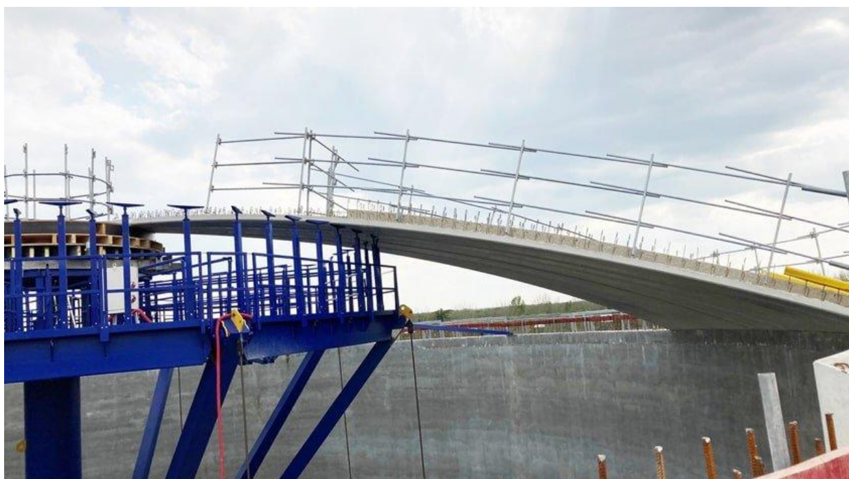
Chaque pétale est équipé de garde-corps de chantier avant d'être positionné sur l'outil-parapluie.
