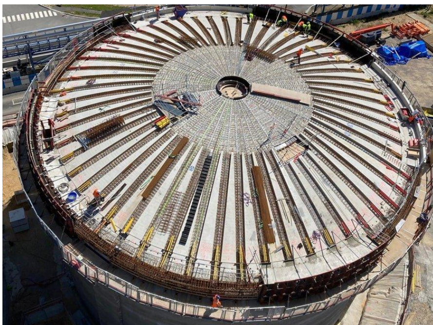
Une fois les pétales posés, la poutre de couronnement est bétonnée et les pétales clavés.
