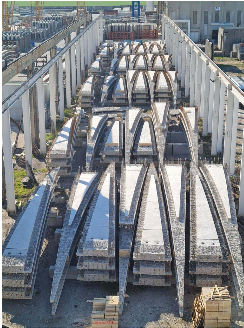
Stockage des « pétales » dans l'usine Capremib, filiale de Demathieu Bard spécialisée dans la préfabrication.
